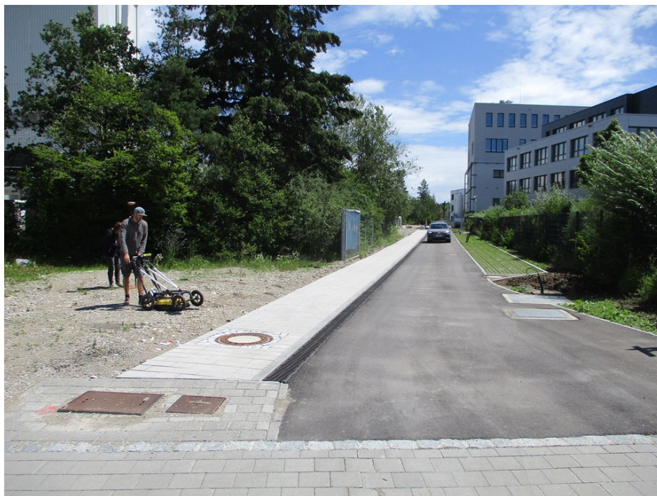
Abb. 1, 04.07.2024: Flurnr. 878/43 (linke Bildseite) u. Freimessung Bohrpunkt KRB 1, Blickrichtung Ost
